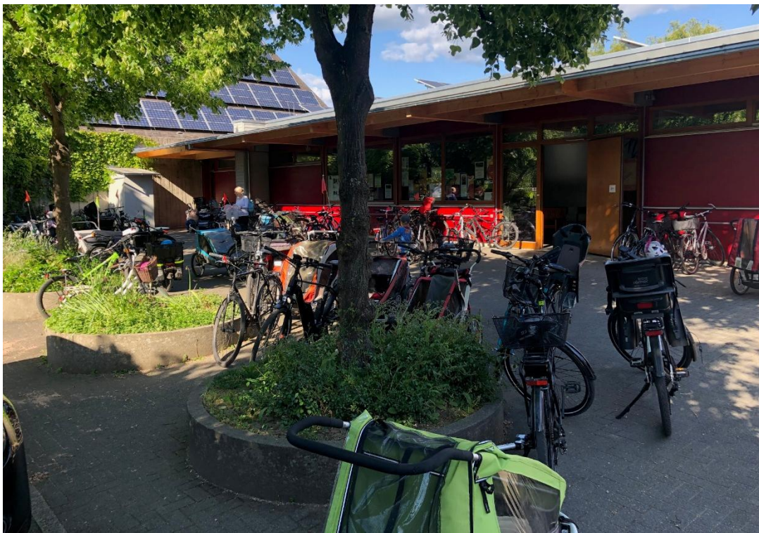
Überdachung vor dem Gemeindehaus St. Peter und Paul, als Abstellplatz für Fahrräder für Gottesdienstbesucher, Mitarbeiterinnen und Eltern des Kindergartens.
