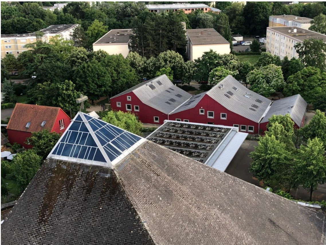
Photovoltaikanlage auf dem Dach des Gemeindehauses und dem Kindergarten
